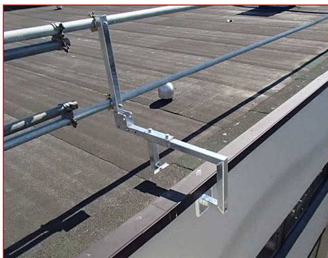
パラペット手摺 Ⅱ型 取付部拡大写真
