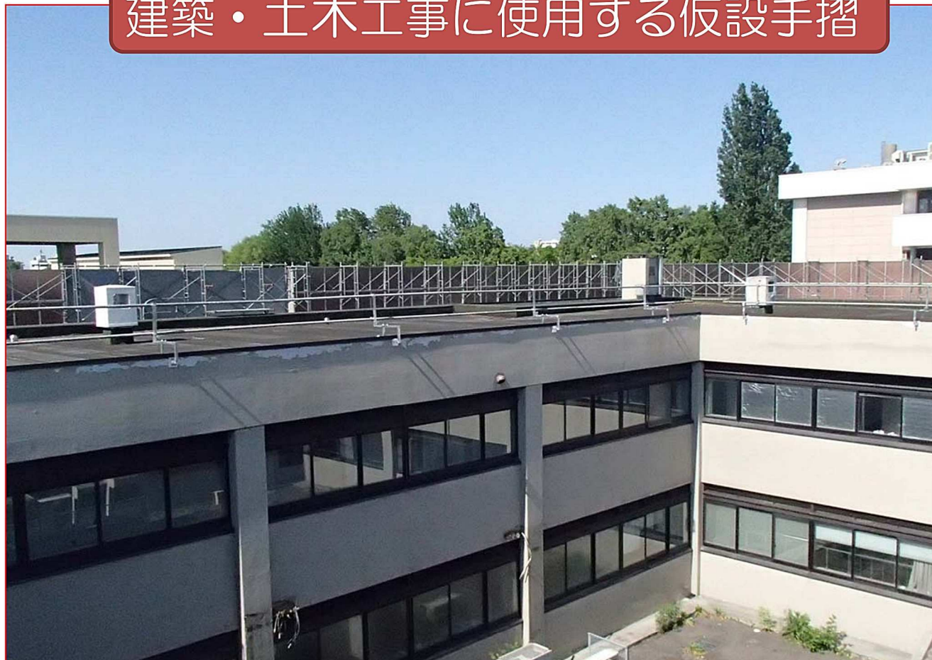
パラペット手摺 Ⅱ型 施行写真
