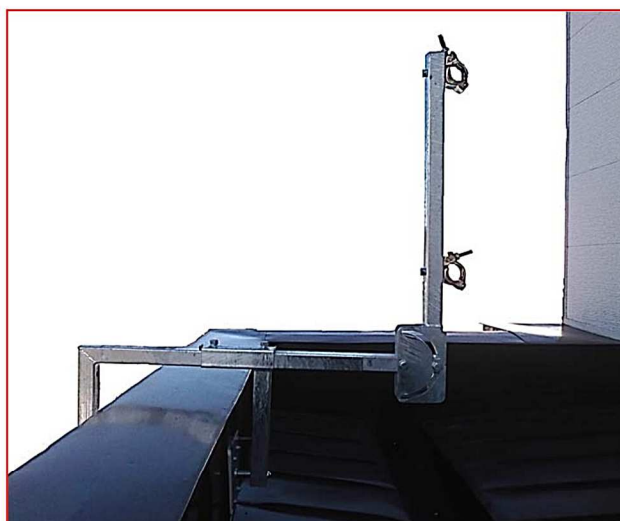
パラペット手摺 Ⅱ型 取付部拡大写真
