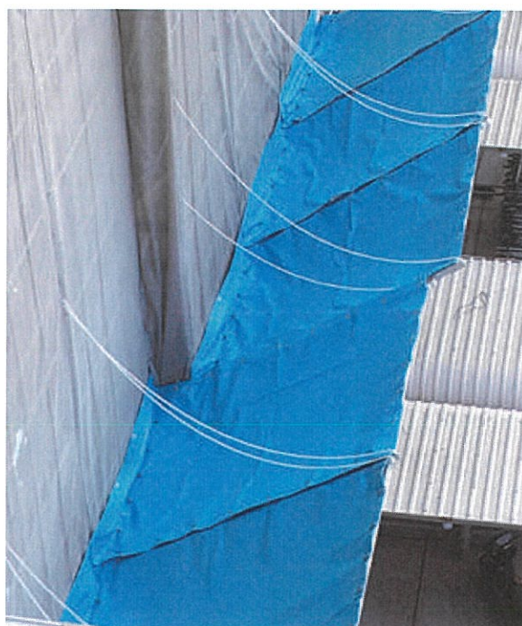
足場と朝顔はシートの折り返して隙間が出来ません
